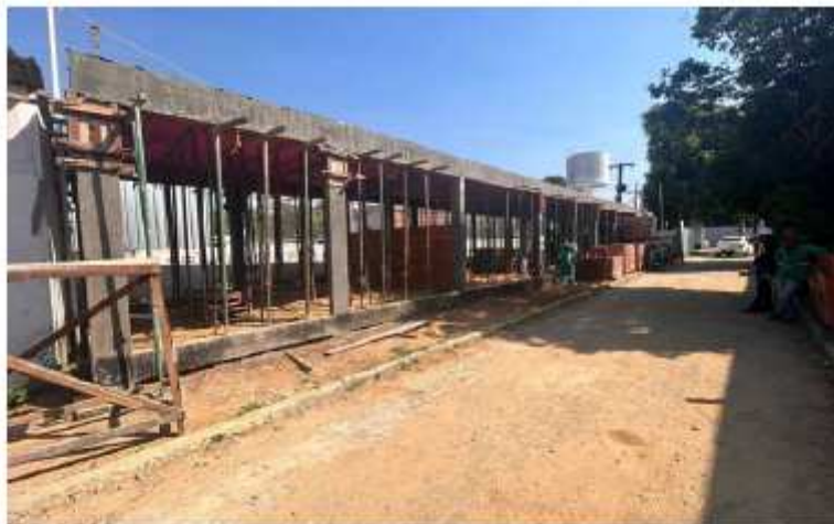
OBRA: CENTRO DE SAÚDE MENTAL – CSM
